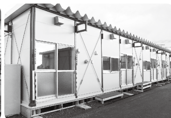
⑦完成間近の仮設住宅
